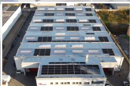
Vista aerea della sede Rotafil con il nuovo impianto fotovoltaico.
